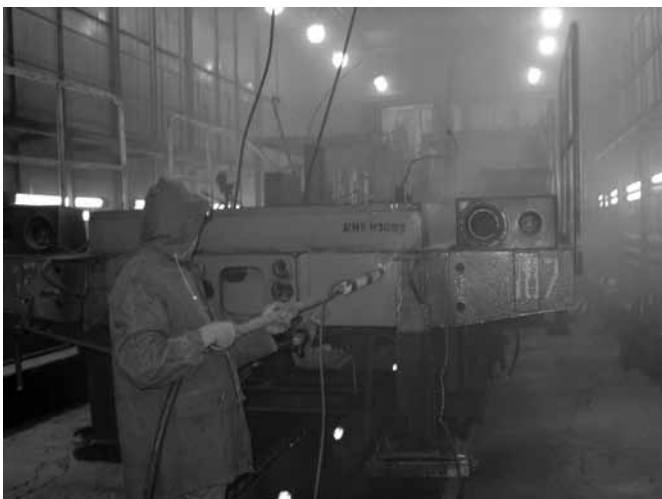
Рис. 1. Очистка поверхности металлоконструкций от застарелого лакокрасочного покрытия
